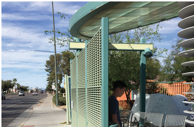
Figura 3 La pantalla perforada paralela a la calzada proporciona sombra en un lado durante todo el día. La perforación es necesaria para permitir ver el espacio sombreado en términos de seguridad.
