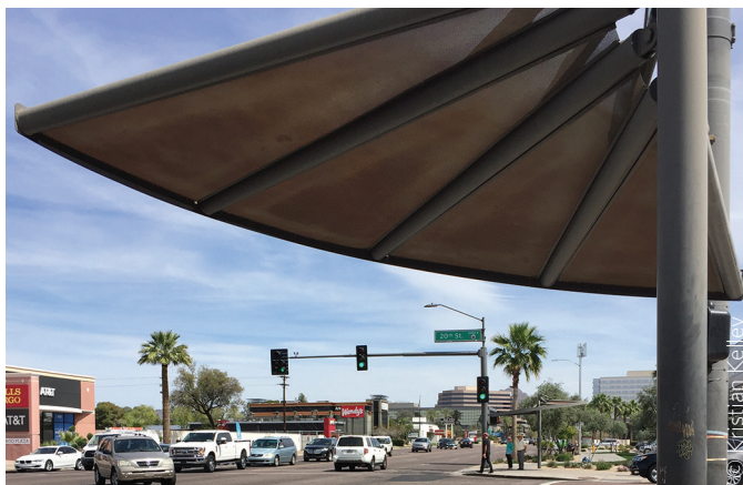
Figura 3 La pantalla perforada paralela a la calzada proporciona sombra en un lado durante todo el día. La perforación es necesaria para permitir ver el espacio sombreado en términos de seguridad.
